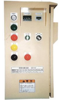
デジタル設定制御盤
